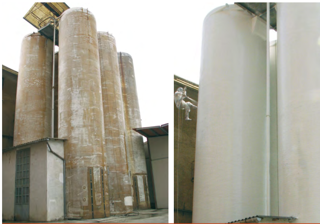
Sili in vetroresina prima e dopo l'apposito trattamento messo a punto dalla On Rope.
